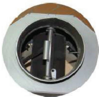
Рис.4.1. Положение заслонки при открытой двери
